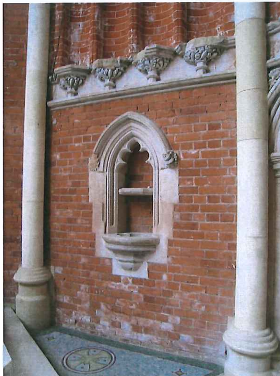
Existing niche (lavabo)
