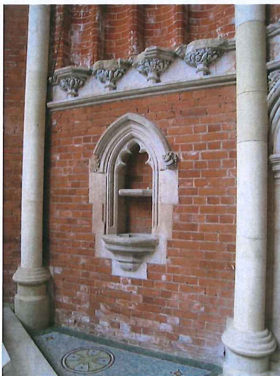
Existing niche (lavabo)
